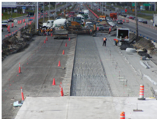
Figure 1 – Construction de la section d'essais en 2006
