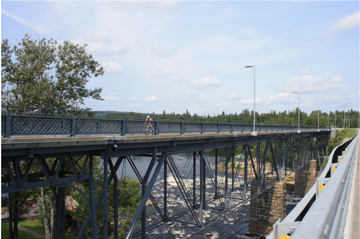
26. Le pont de Shannon restauré.
