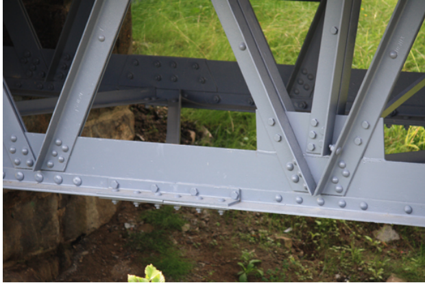
19. Quelques boulons à tête ronde ont été ajoutés ou ont remplacé certains rivets d'origine.
