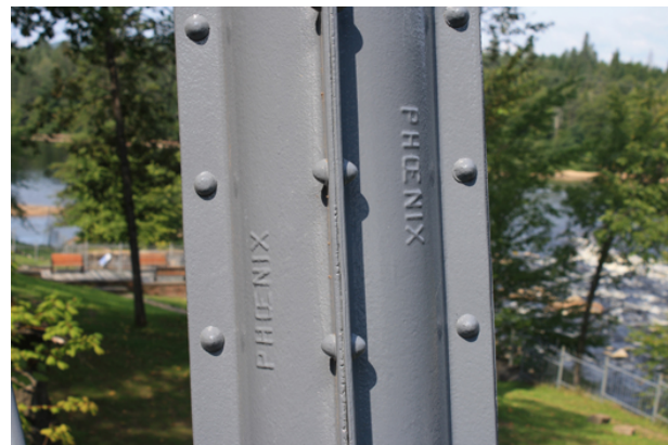
6. Détail d'une colonne Phoenix où l'on voit clairement le nom de la compagnie sur les différentes pièces la composant.
