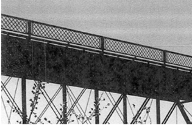
15. Une photographie ancienne datant des années 1960 a renseigné l'équipe de conception de la présence d'un garde-corps treillissé.
