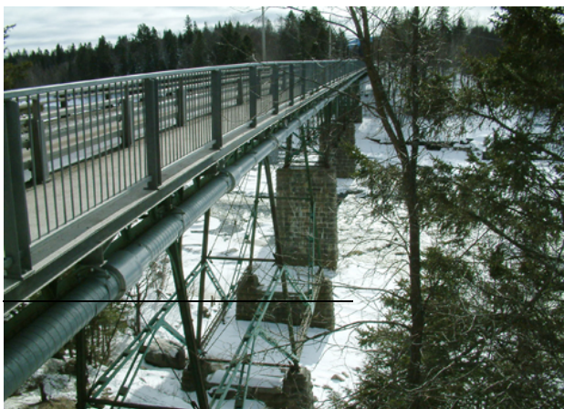
11. Trottoir en porte-à-faux ajouté du côté ouest de la structure en 1997 et démolé en 2017.
