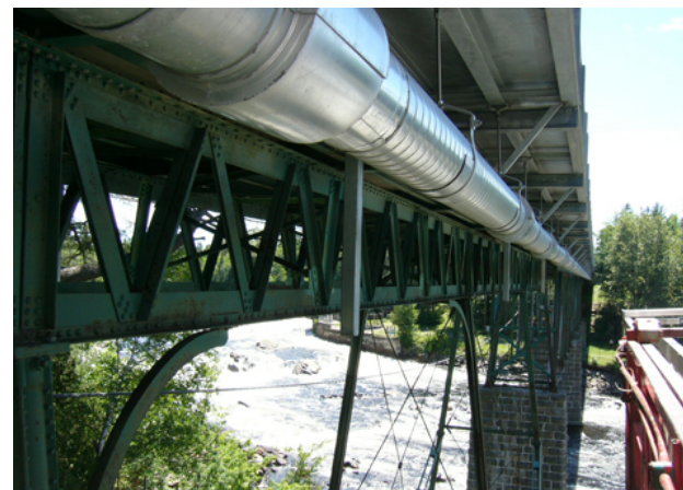
12. Conduite d'aqueduc accrochée sous le trottoir en 2004 et déplacée sous la structure en 2017. Source : MTQ.
