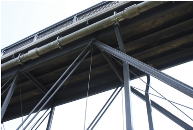
22. Les drains verticaux, peints de la même couleur que le pont et ramenés à l'intérieur de la structure, se confondent à l'ensemble restauré.
