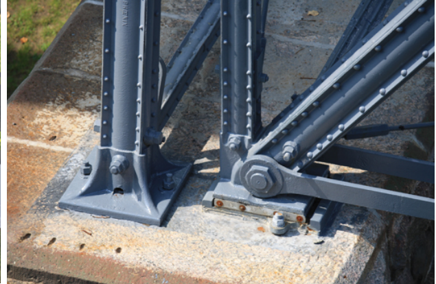
20. Appareils d'appui qui ont été reconstitués à l'identique.
