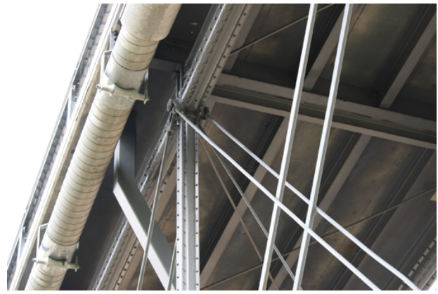
23. La conduite d'aqueduc de la Ville de Shannon (à gauche) a été déplacée sous le débord du tablier du pont.
