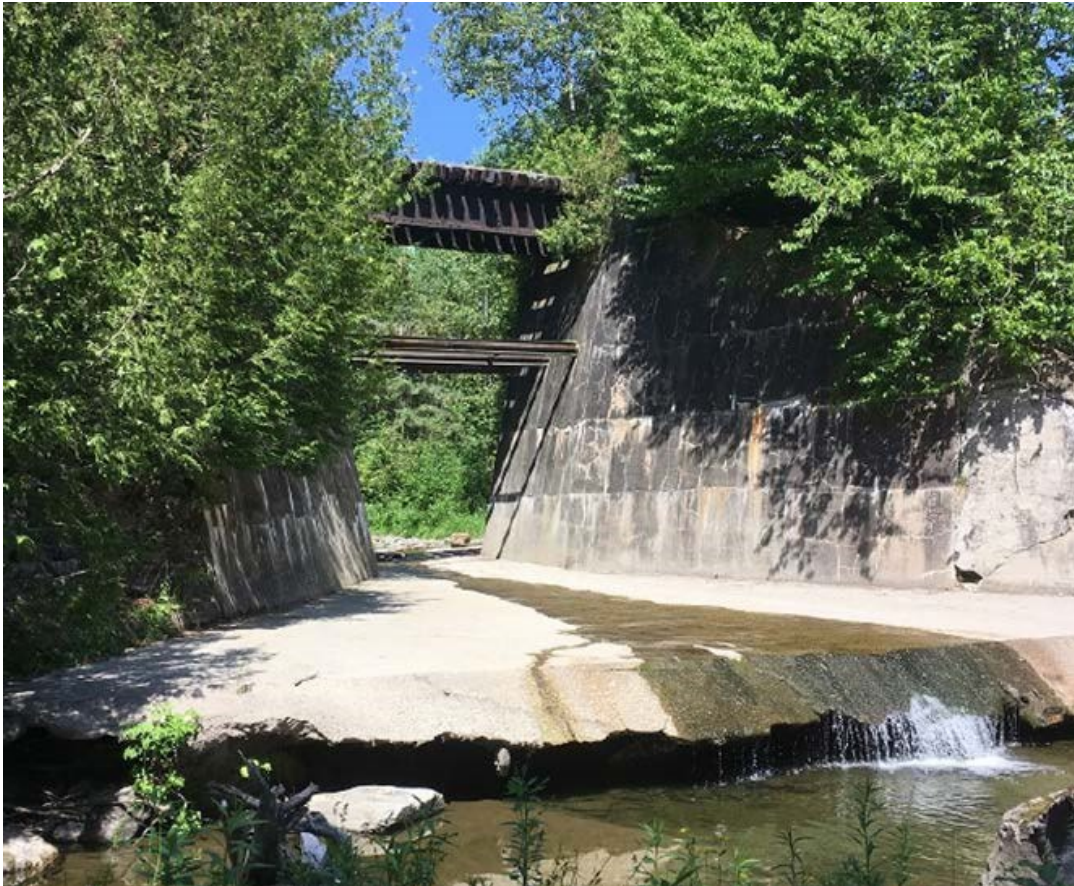
Pont au-dessus de la rivière Cliche
