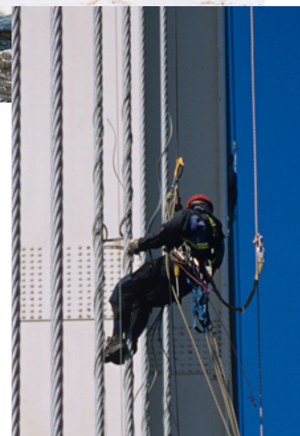
Inspection en appui sur cordes
